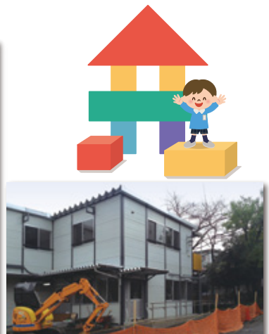
建設中の仮園舎
