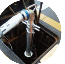
スタンドパイプ スピンドルドライバー、ホースなどがセットになっています。車輪付きで軽いうえ移動も簡単です。
