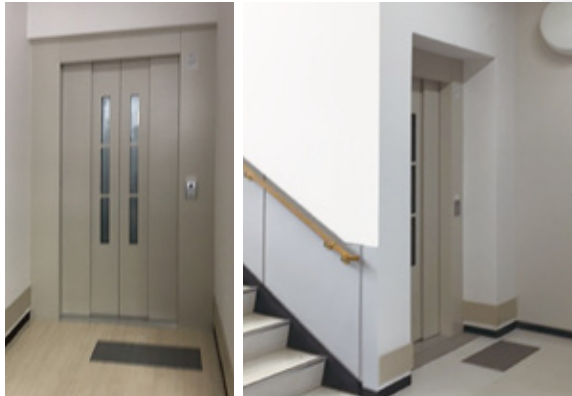
西館学習室入り口エレベーター
